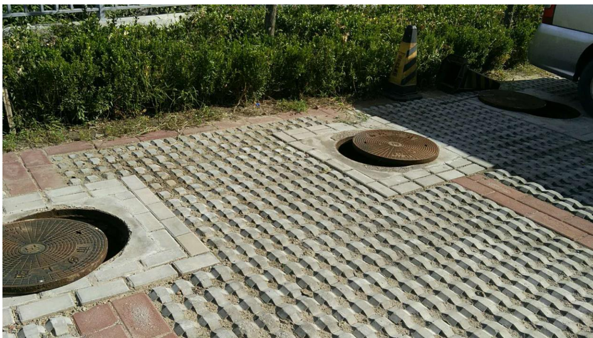
图 4-1 本项目化粪池
